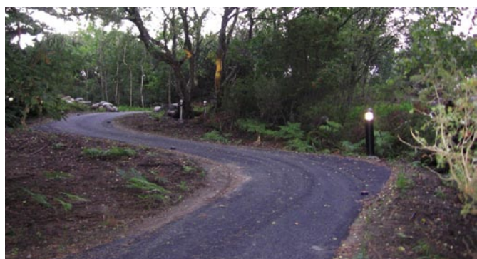
Arbetet med Sinnenas promenad etapp 1, fortsätter i takt med att gåvor och bidrag kommer in till Vänskapsföreningen.
